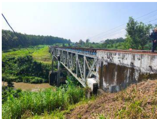
Gambar 2. 17 Monitoring Kondisi Jembatan BH 397 BH 537
