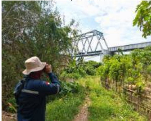
Gambar 2. 18 Monitoring Kondisi Jembatan BH 537 Pasca
